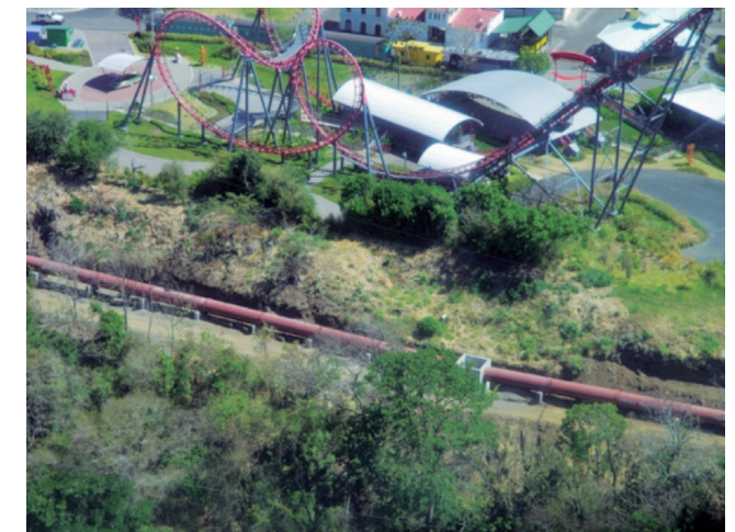
Foto aérea de la construcción del Emisario Metropolitano detrás del Parque de Diversiones.
