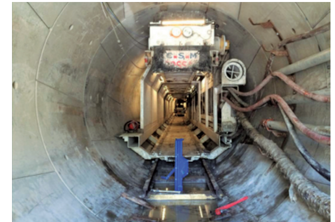
Fotografía a lo interno del Túnel, a octubre 2015 con una distancia de 1.000 metros.
